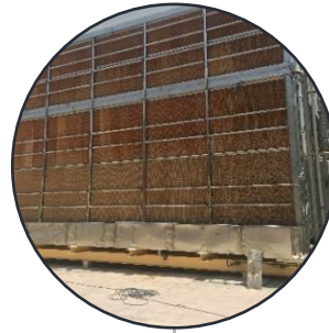
اجزا سامانه خنک کاری تبخیری هوای ورودی توربین گاز تابا
