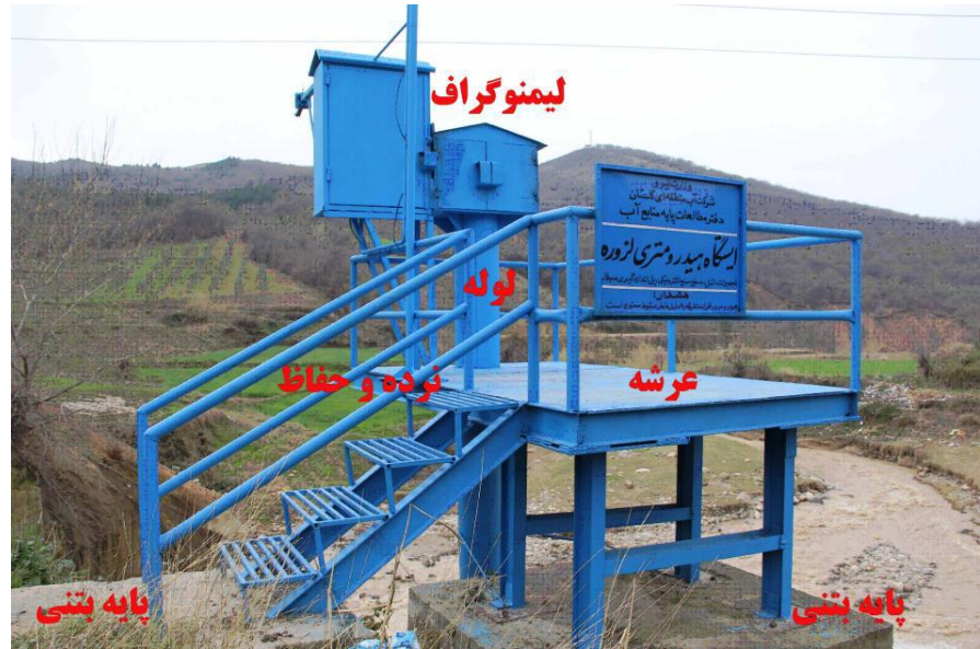
اجزاء ایستگاه هیدرومتری
