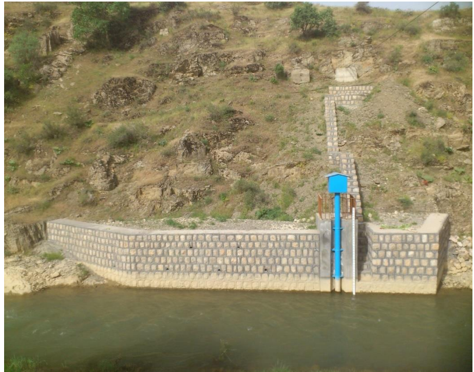
ایستگاه هیدرومتری از نمای روبرو و دیواره سازی ایستگاه
