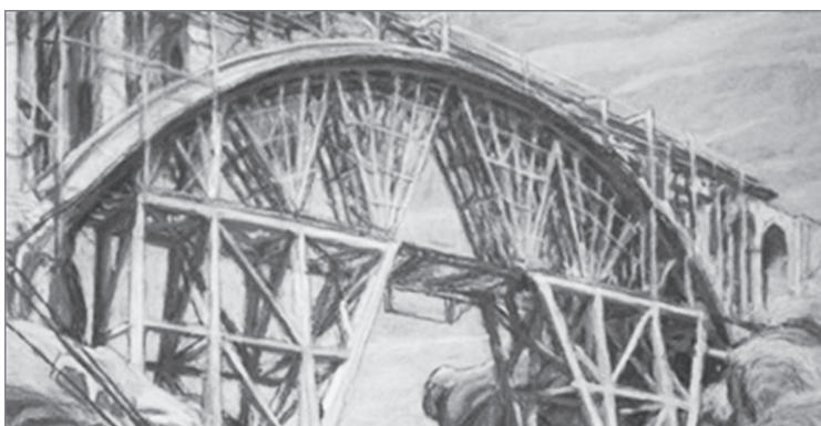
▲ یک نمونه از نقاشی‌های مهندسی ورسک این تصویر است که پل ورسک را در مرحله اتمام بخش قوسی و ستون‌های نگهدارنده تاج پل نشان می‌دهد
