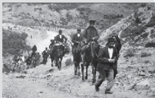
► کارگران در حال حرکت به سمت کارگاه ورسک
