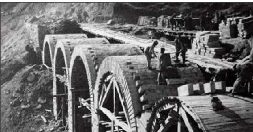
▲ نمایی از کارگران در حال ساخت پل ورسک
