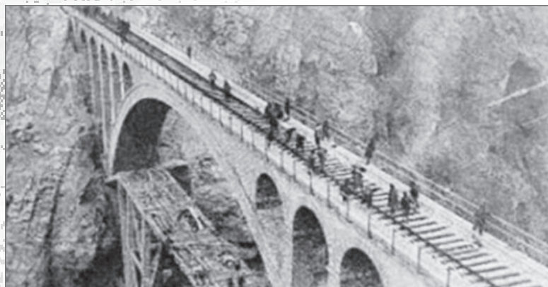
▲ نمایی از عملیات ریل گذاری روی پل ورسک
