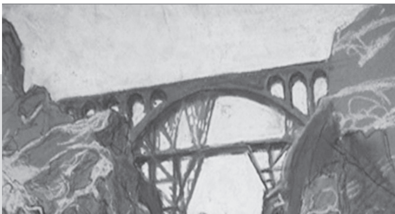
▲ نقاشی بعدی پل ورسک که توسط مهندس ورسک (لادیسلاوس فون رابسویچ) کشیده شده است، مراحل آخر ساخت پل ورسک در زمستان سال ۱۳۱۴ را نشان می‌دهد. همچنین در پایین عکس، تونل زیر رودخانه و بر روی آن کانال هدایت رودخانه دیده می‌شود.
