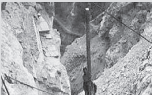
▲ نمایی از کارگران در حال احداث داربست پل ورسک
