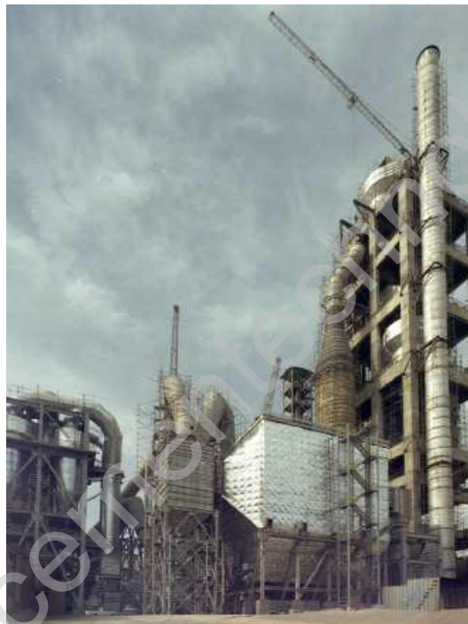
واحد هشتم سیمان تهران اولین کوره دو پایه در ایران که در سال 1385 راه اندازی شد.
