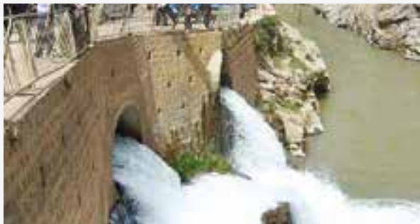
آب چشمه از راه لوله فولادی، نزدیک به ۹۰ متر به گونه خودبرآی بالا آمده و در کانال روان است. دهانه لوله در کف کانل دیده می‌شود. (۳ متر مکعب در ثانیه)
