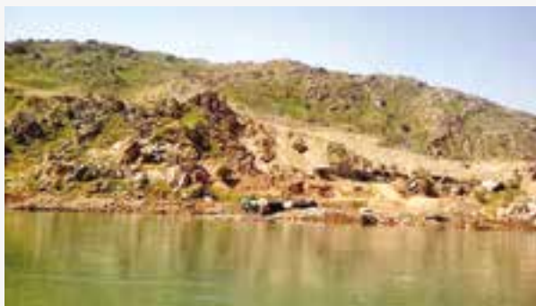
❏ پوشش رسی روی برونزد نمک در مخزن سد گتوند که نمی‌توانست راز پوشانی کند!
